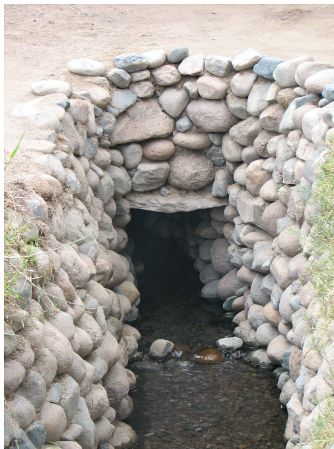
Ryc. 4 Kamienna płyta tworząca sufit podziemnego tunelu (fot. J.Wanot)
